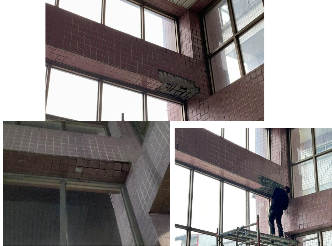
磁磚掉落、牆面裂痕(地震後造成)
