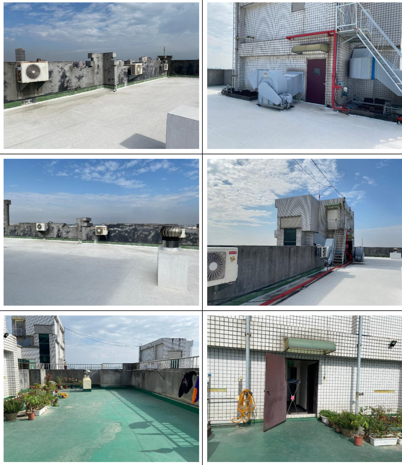
屋頂防水部份已自行施作完成
