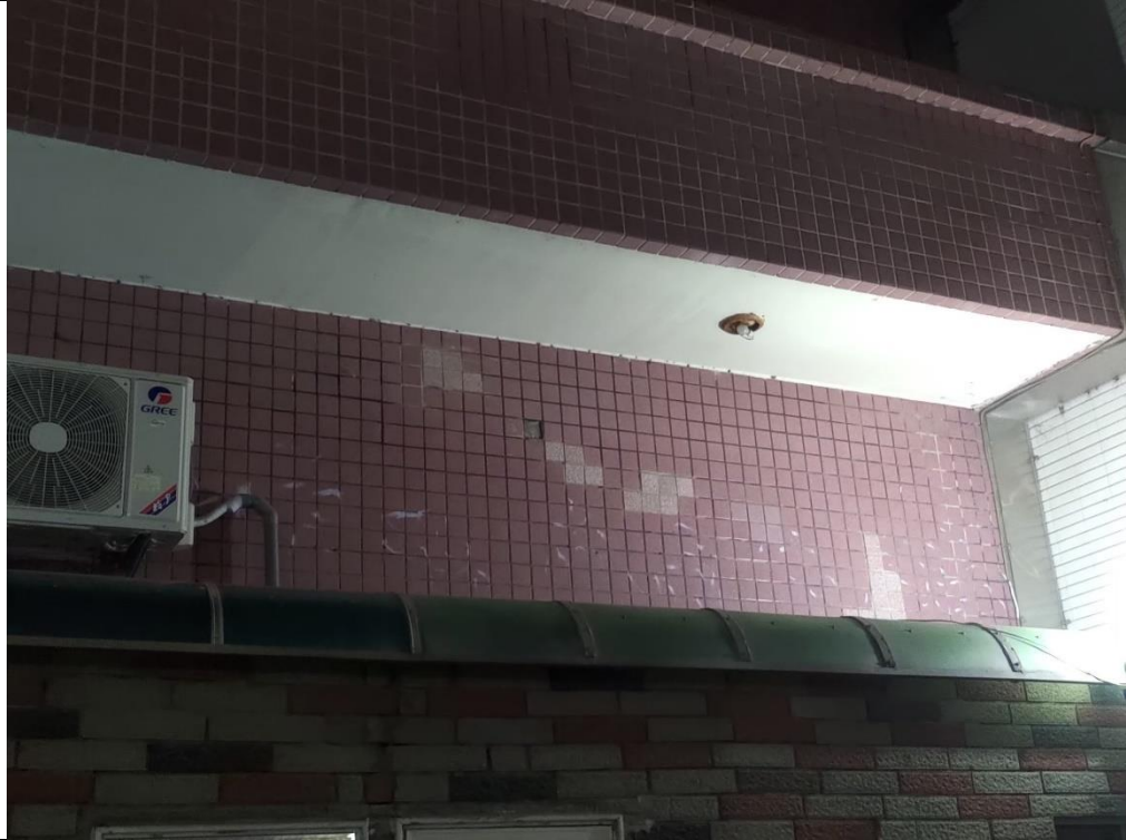
磁磚掉落、牆面裂痕(地震後造成)
