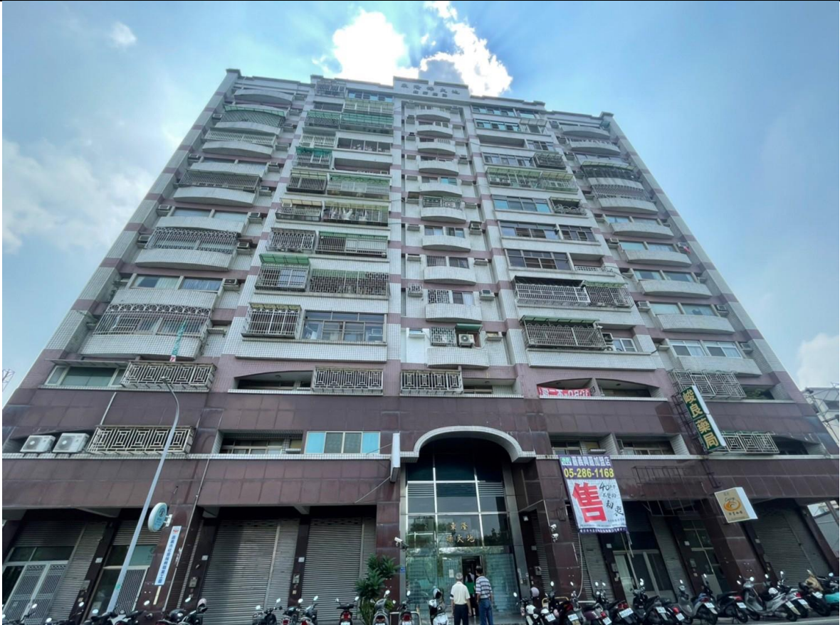
建築物北側立面(臨大同路) ①
