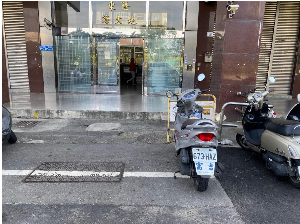
社區北側騎樓與路面有高低差，以及部分中庭處有稍微高低差。
