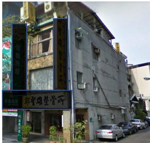
背(側)向立面照片
